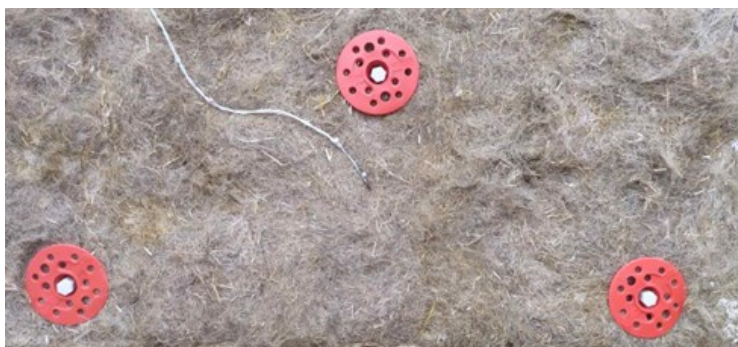
Рис. 9. Монтаж утеплителя на кирпичной стене
